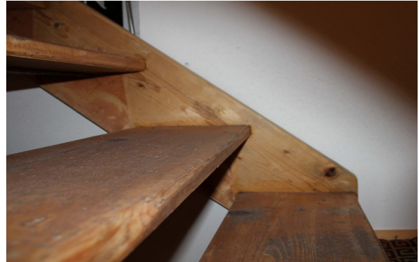
Treppe (mascil-Team Austria)
