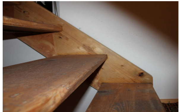
Treppe (mascil-Team Austria)
